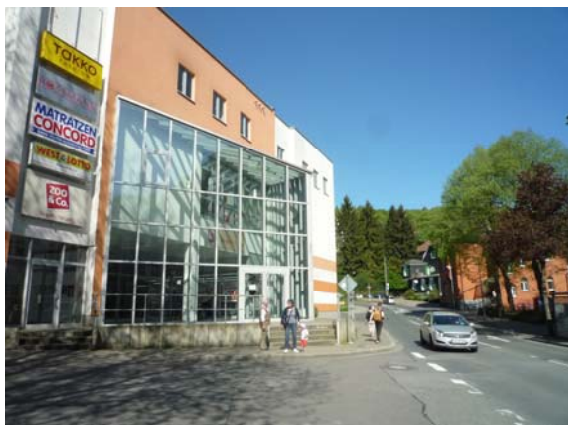
Abbildung 13: Eingangsbereich des Heilenbecke-Centers von der Voerder Straße
